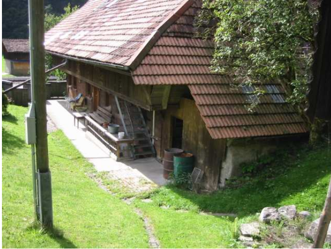
Ostfassade von norden her.
