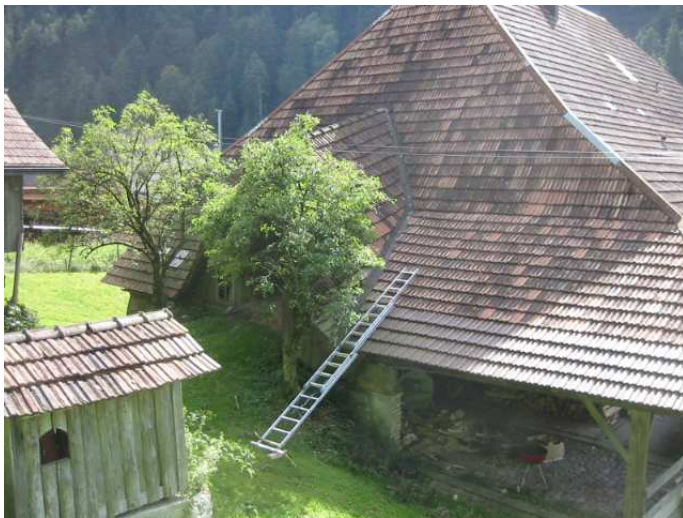
Nordfassade mit der bestehenden Hocheinfahrt zwischen den Bäumen.
